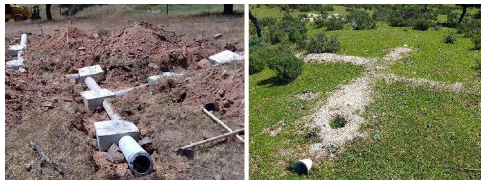
Figura 43. Los vivares y refugios con tubos y cámaras de hormigón se pueden montar subterráneos, enterrados a medio metro, si son suelos sueltos y que drenen bien (fotos FCBDH).
