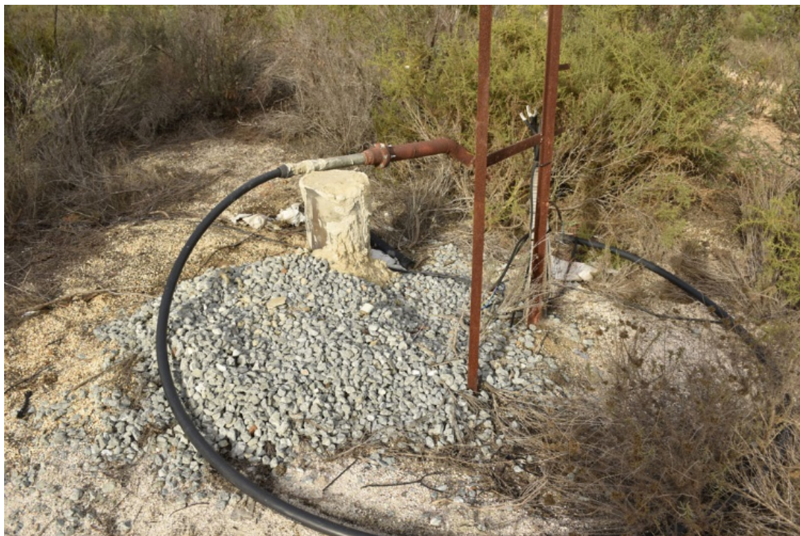
Ejemplo de pozo ilegal en el entorno de Doñana. Estas extracciones escapan al control de la administración pública del agua e impiden en conjunto completar de forma adecuada los balances hídricos del sistema acuífero Almonte-Marismas. © Jorge Sierra/ WWF España
