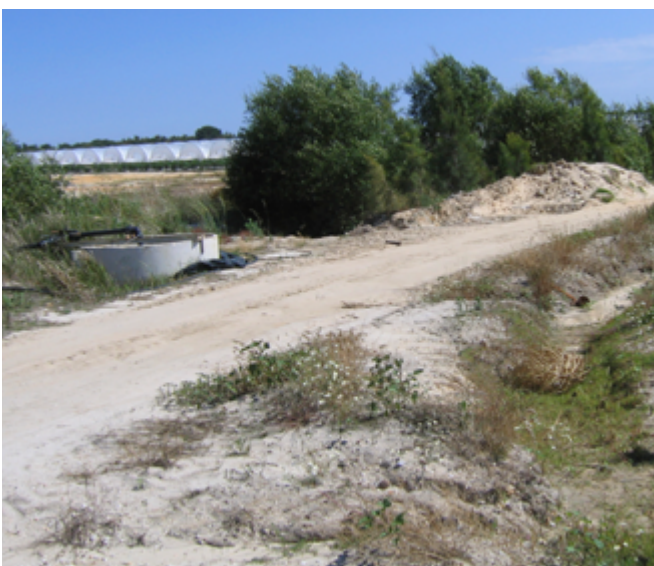
Captación en cauce de aguas.
