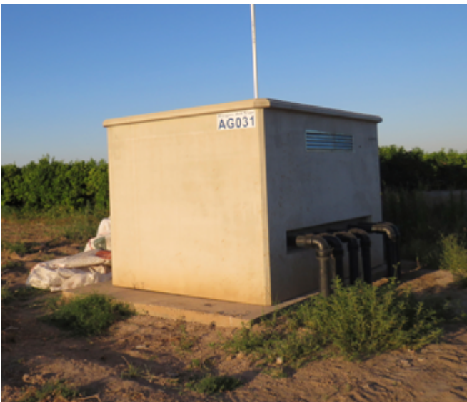
Caseta de comunidad de regantes.
