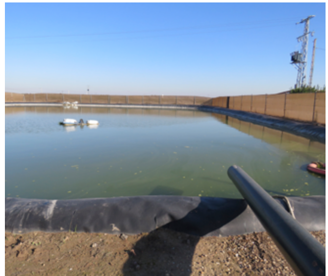
Entradas de agua a balsa de regulación.
