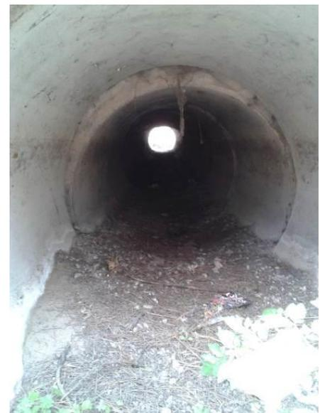
*Las imágenes de la derecha, muestran el canal de drenaje existente bajo la carretera en el tramo de atropellos que no sirve como paso adecuado para anfibios por no presentar las características adecuadas.*
