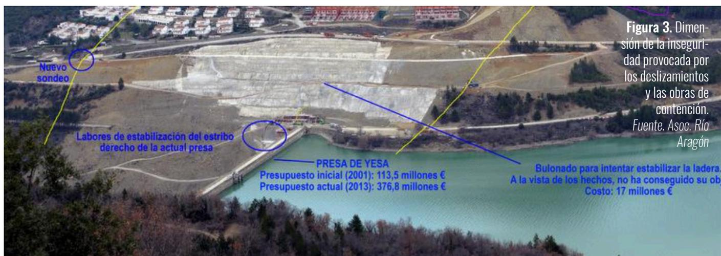
**Figura 3.** Dimensión de la inseguridad provocada por los deslizamientos y las obras de contención. Fuente. Asoc. Río Aragón
