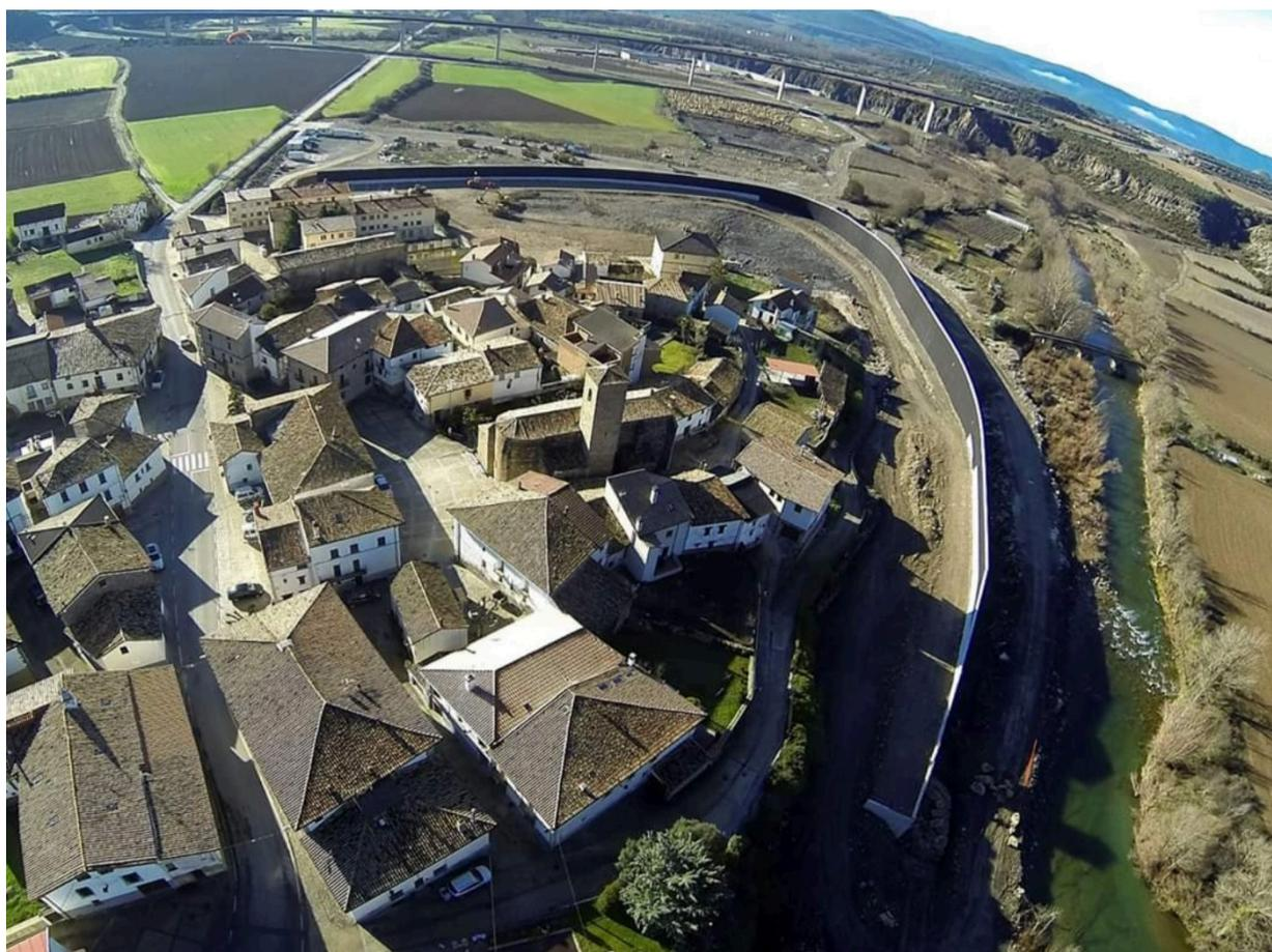
Figura 12. Muro de Sigües en construcción desde 2018 para la contención de la llegada de las aguas del recrecimiento de Yesa. Fuente. Asoc. Río Aragón
