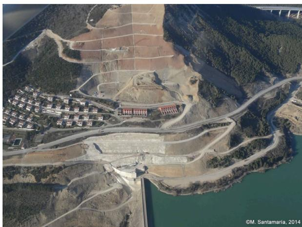
**Figura 4.** Ladera derecha con graves deslizamientos en 2014 tras las primeras obras de emergencia.
