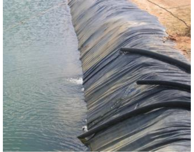
تفاصيل مداخل مياه في حوض منظم لها.
